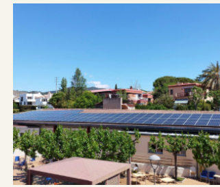
Instal·lació plaques solars a Can Torras
